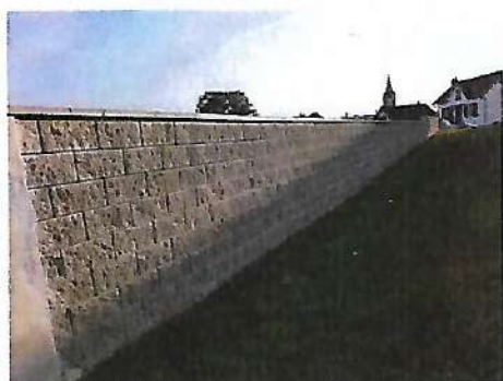
Réfection du mur du cimetière : - coût avec participation de la CCST : 29 435,40 €
